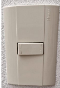
Figura 1.- Interruptor electromecánico que se puede encontrar comúnmente en el hogar para el control de luminarias (imagen de elaboración propia).
