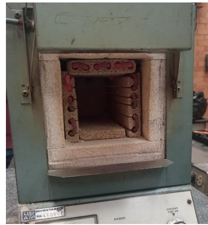
Figura 10.- Prueba de funcionamiento de resistencias y placas. (Autoría propia)
