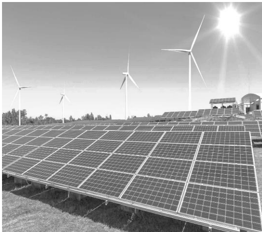
Figura 1. Energía solar fotovoltaica
