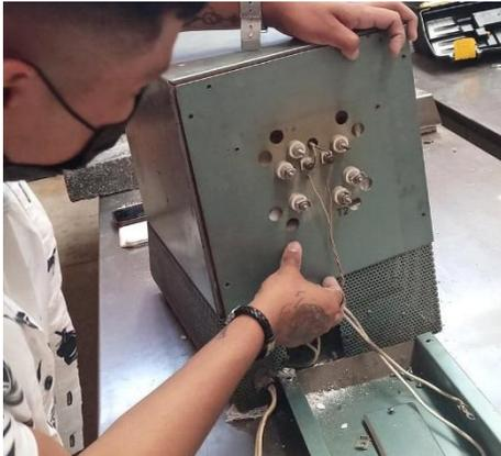
Figura 4.- Desconexión de los cables. (Autoría propia)
